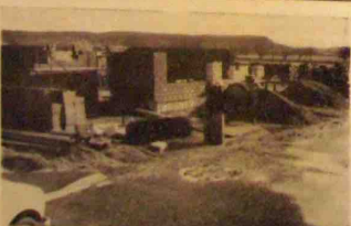
Vue partielle des constructions en cours à La Croix Blanche.
