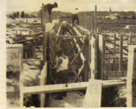
Vue partielle du coulage des fondations.
