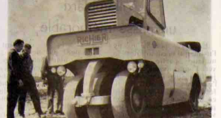
Que de mètres cubes de terre, ce « mastodonte » a déplacé !
