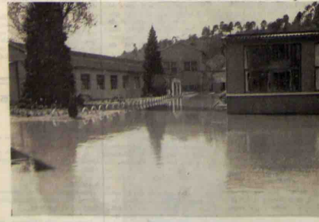
Vue de l'inondation entre les bâtiments de fabrication
