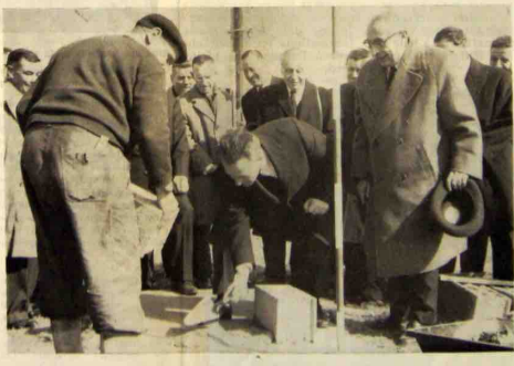
CI-dessous : Sur les conseils de M. J. DAGAND, M. TAULELLE, assisté d'un Maître-Ouvrier, procède à la mise en place du premier élément de l'édifice.
