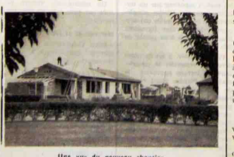
Une vue du nouveau chantier
