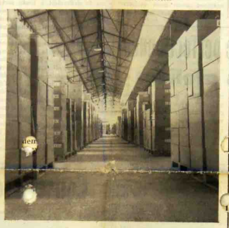
Vue de l'allée centrale
