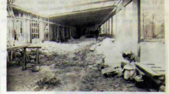
Une vue du chantier en bonne voie
