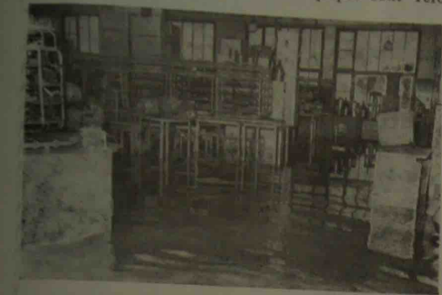
Comme on le voit, des précautions ont été prises, et tout ce qui risquait d'être détrôné par l'inondation a été surélevé
