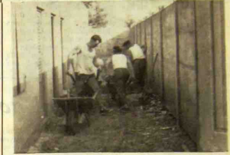
Devant les vestiaires, on procède au cimentage de l'allée
