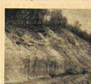
ci-contre, le ramblai glisse vers la rivière
