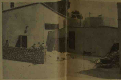
Le chantier nuait il y a quelques semaines à l'emplacement de l'ancien parc à charbon.
