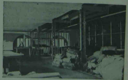
Une vue du Chantier
