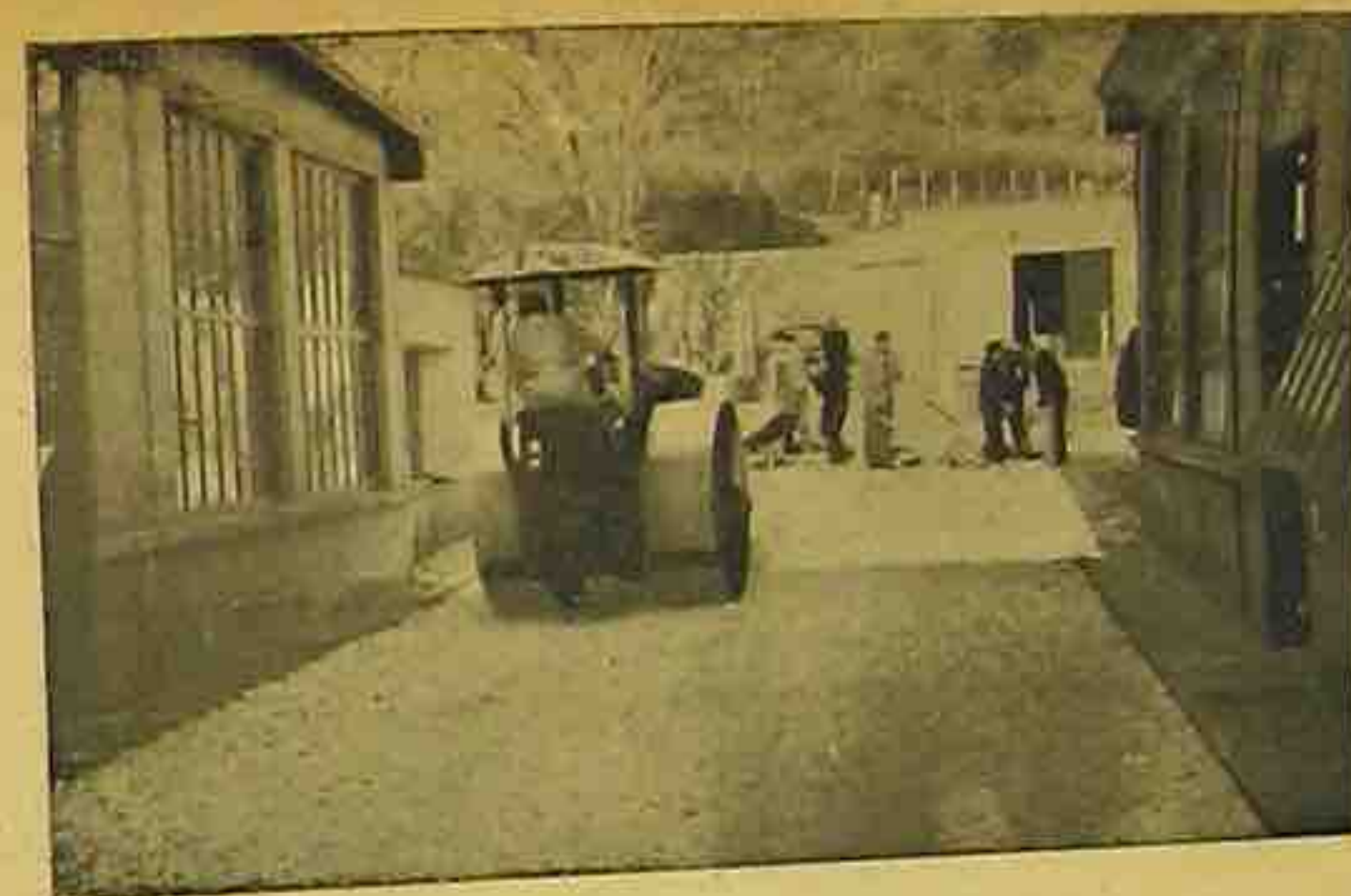
Une vue des travaux d'aménagement de la route d'accès au pont
