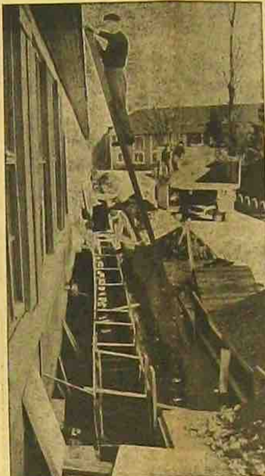
Rapidement les canalisations s'ouvrent et le coffrage est placé
