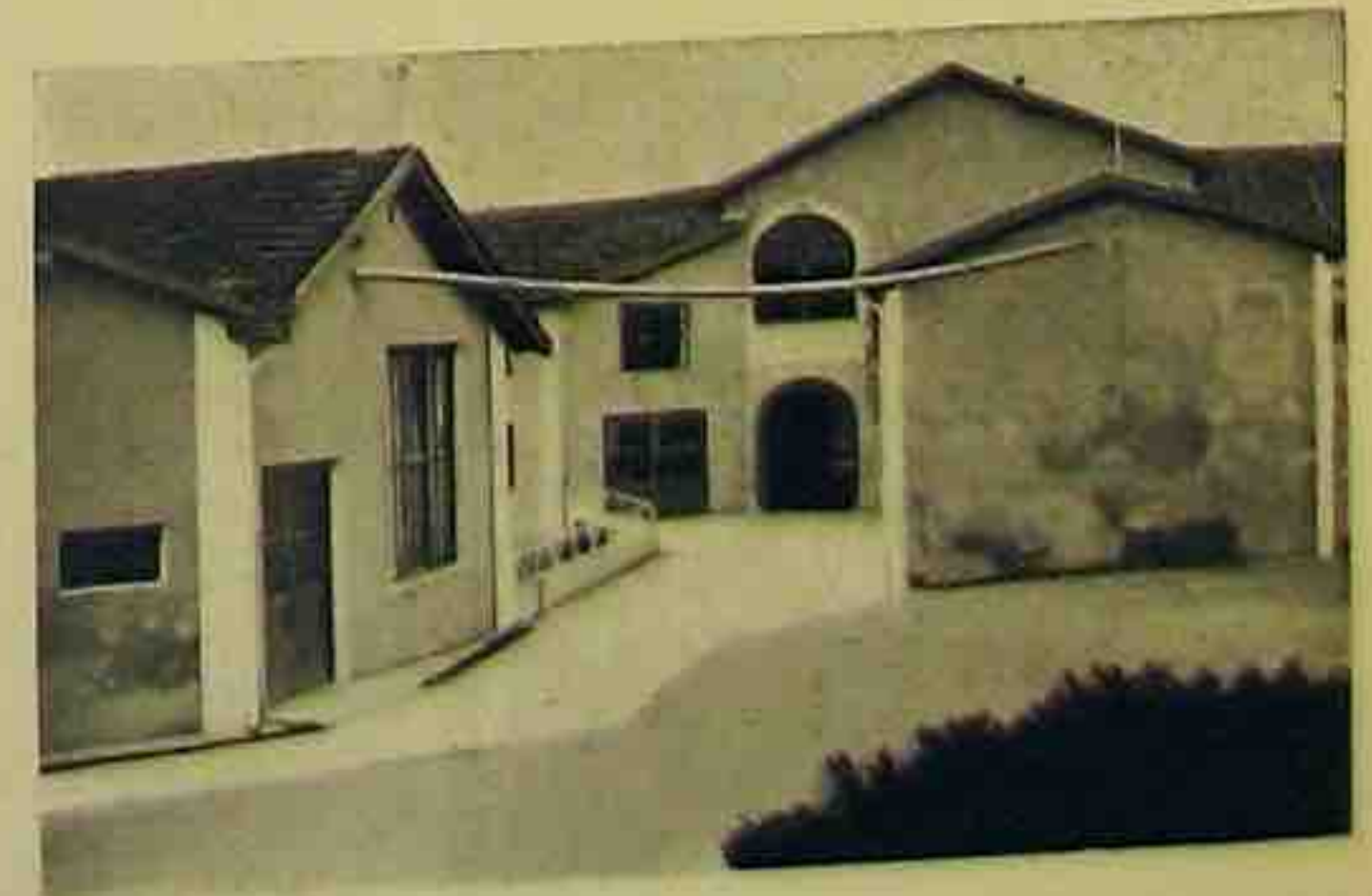
La cour d'entrée
