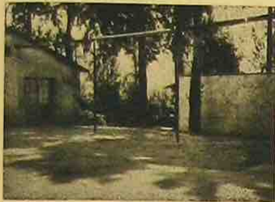
La place centrale de l'usine est maintenant dégagée
