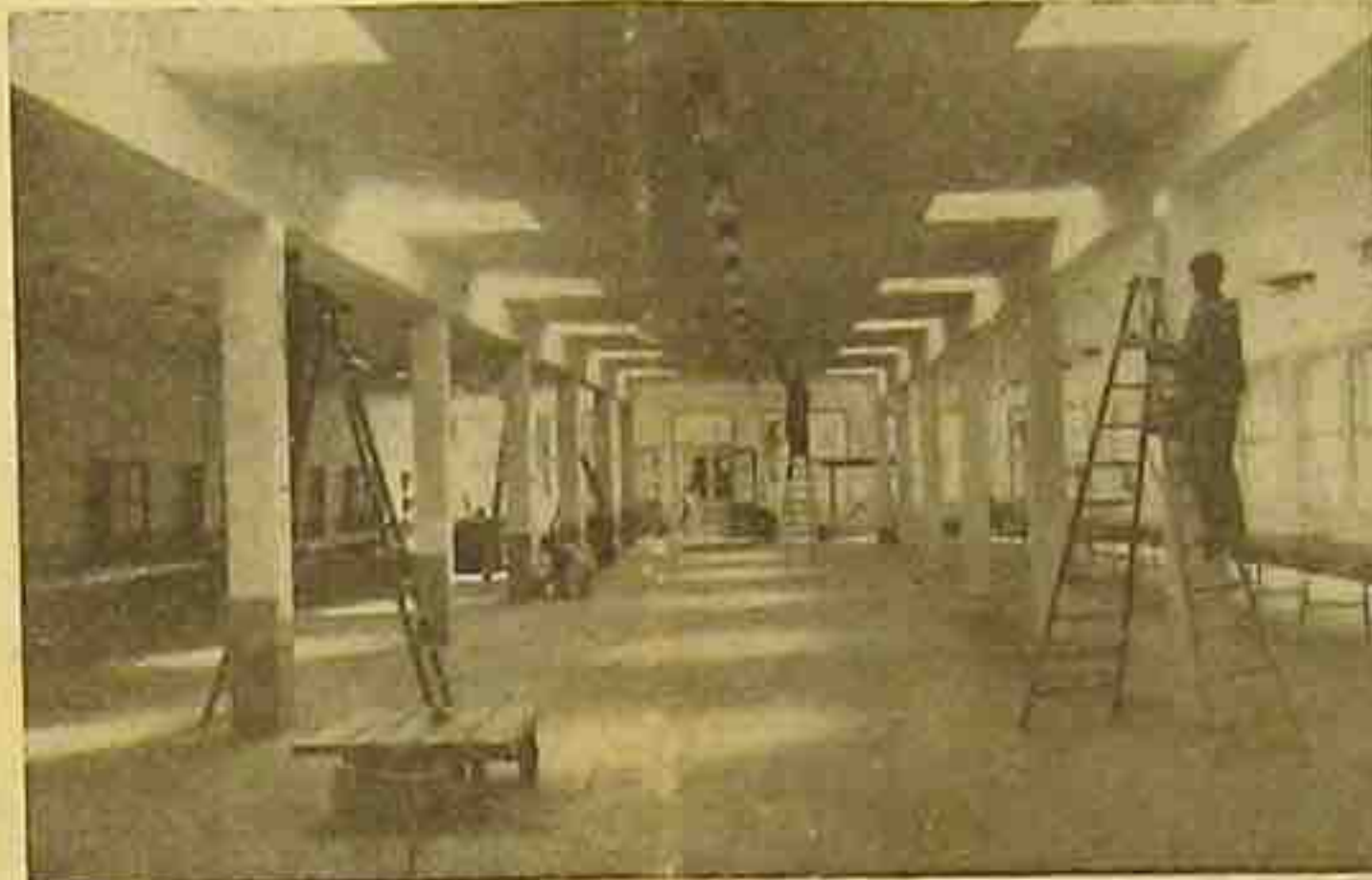
Encore deux jours et c'est la rentrée; les ouvriers du 770 fournissent le dernier effort pour terminer le nouvel atelier.
