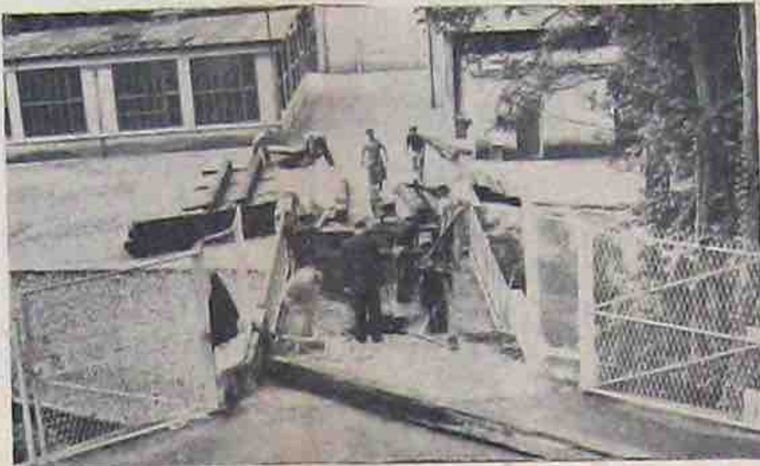
Une vue du chantier pendant la remise en état du pont.
