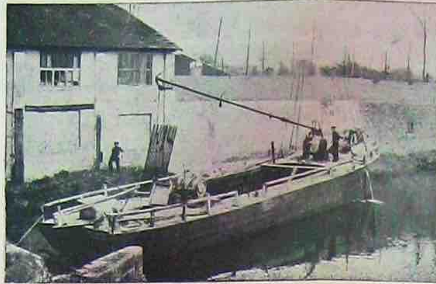
Enlèvement des grilles
