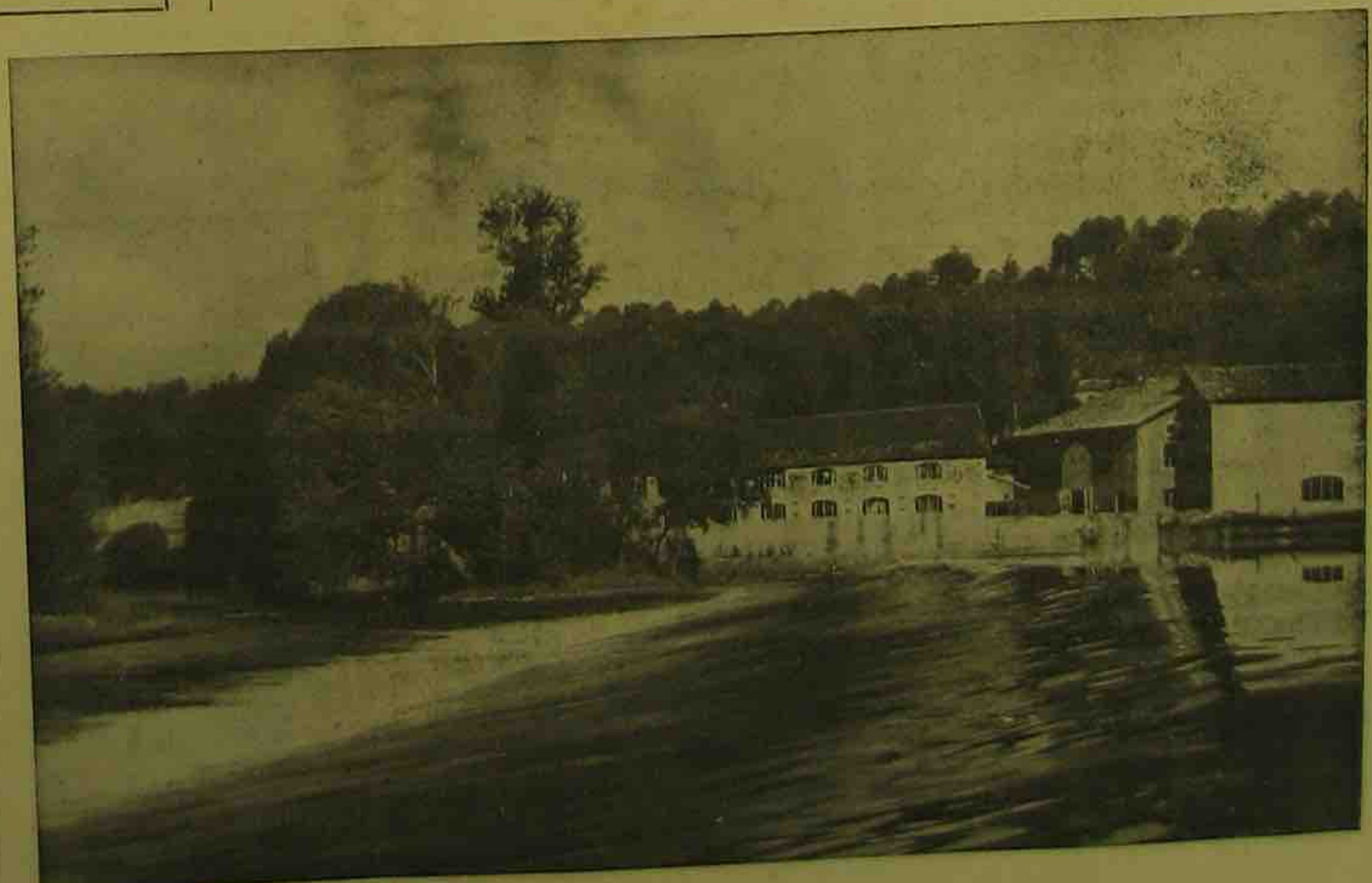
Vue partielle de quelques bâtiments de notre Usine
