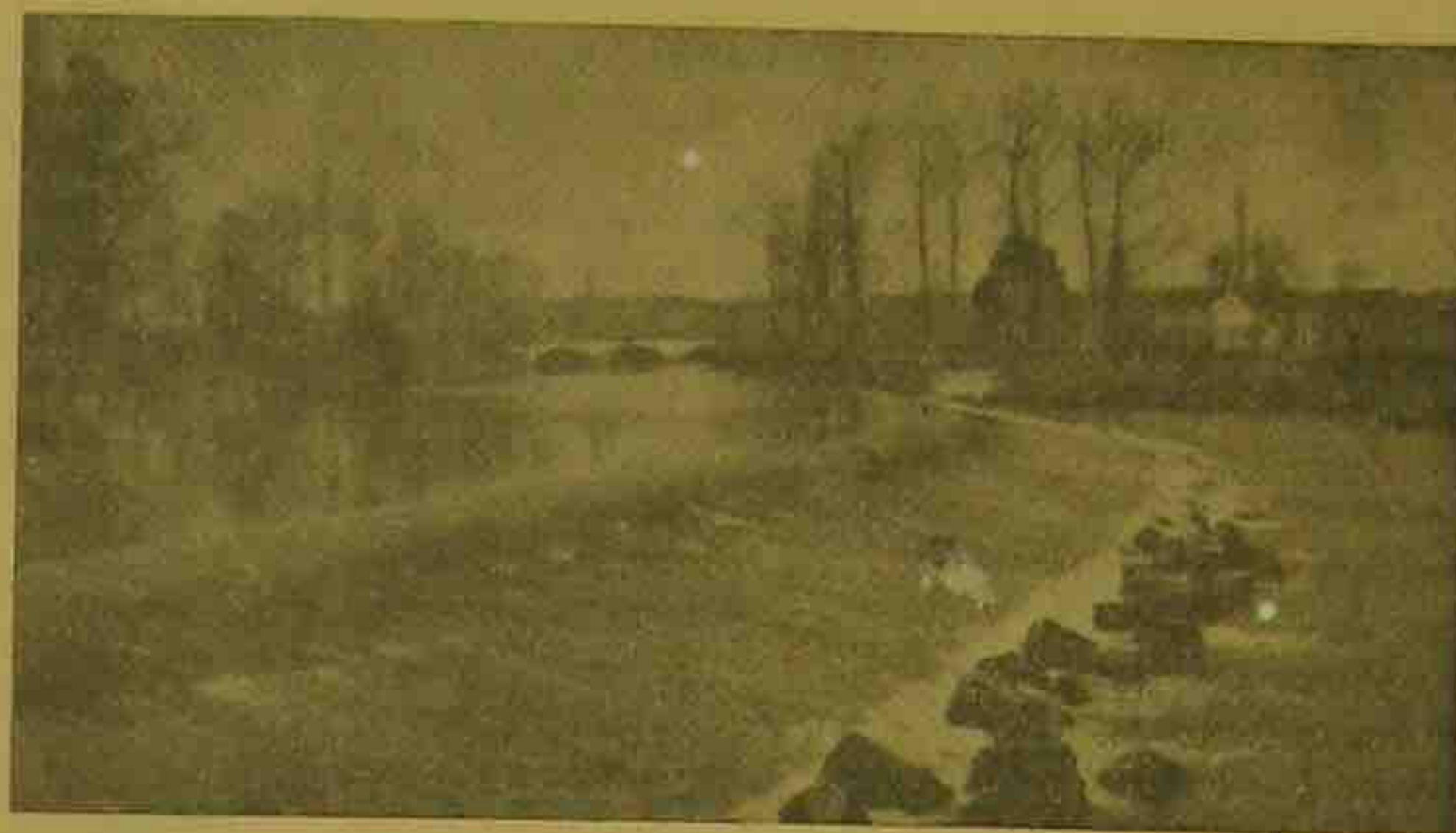
Le barrage de l'Usine
