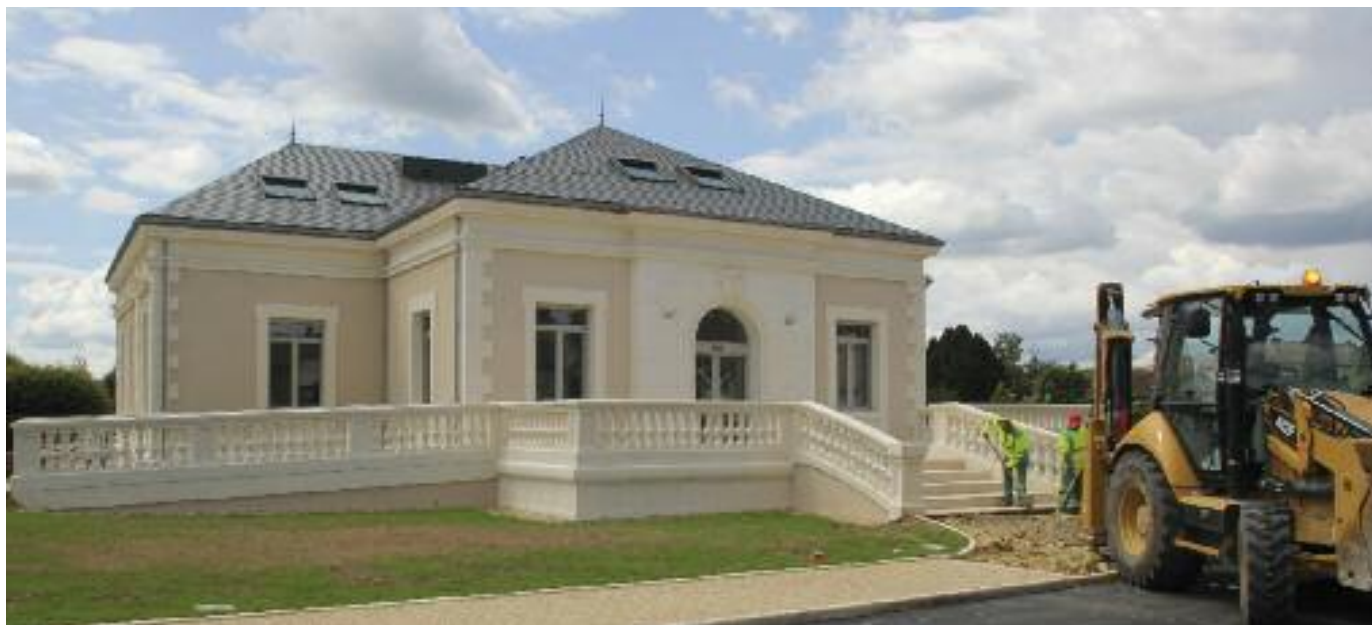
Aménagement de l'entrée principale en cours d'achèvement.
