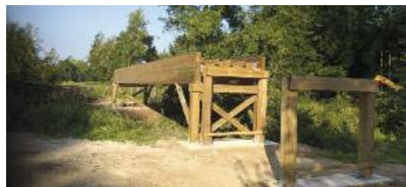
Passerelle sur le « Cul du Vern »
